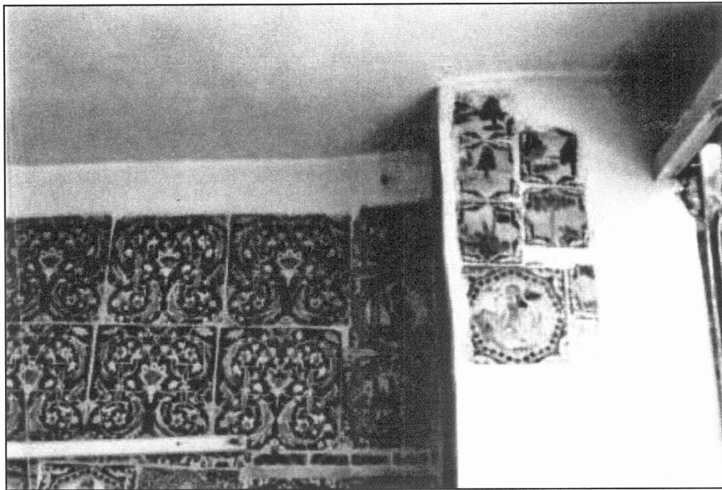
۲- دیوار ضلع شرقی
